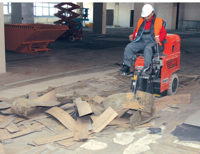
Insgesamt 13.000 Quadratmeter alte PVC-Bodenbeläge wurden im Rahmen einer größeren Umbau- und Sanierungsmaßnahme entfernt.
