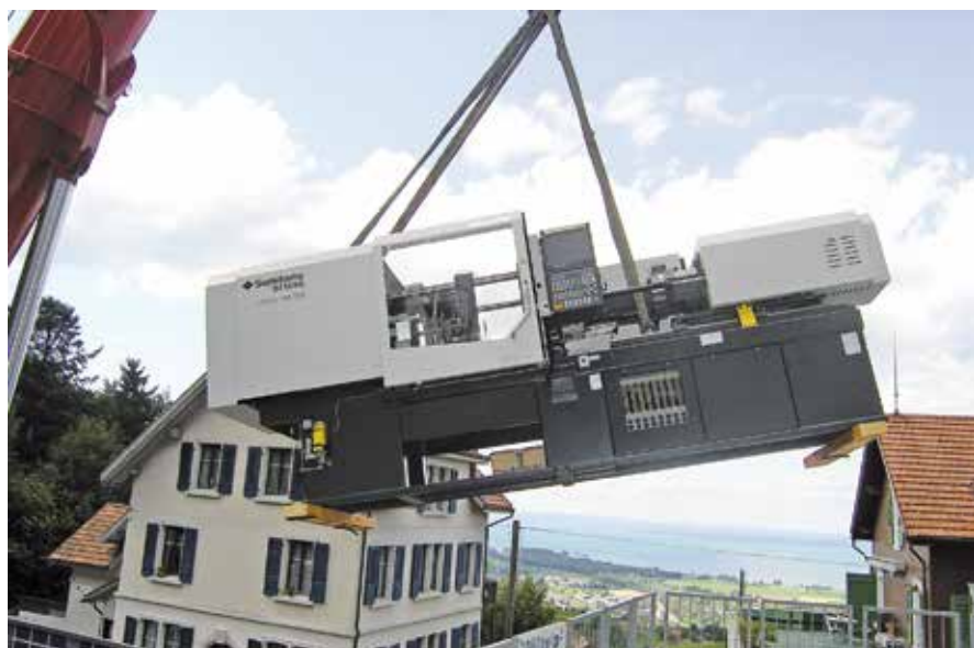
Die Installation einer neuen Spritzgießmaschine bei Betrieben in hügeligem Gelände erfordert gelegentlich Kreativität und einen großen Kran.
