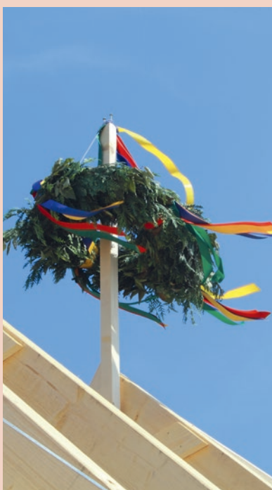
Das PTC feiert Richtfest
