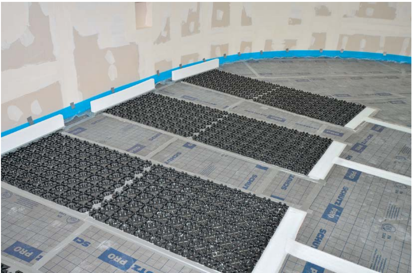
Verlegung von AIRCONOMY® in der Rundung des elliptischen Atriums. Foto: SCHÜTZ ENERGY SYSTEMS
