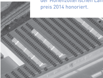
Photovoltaik-Anlage auf dem Dach des Firmengebäudes 2008
