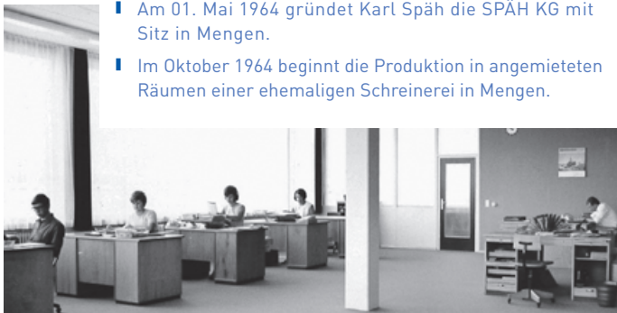
Büroteilansicht in den Anfängen der Firma 1967
