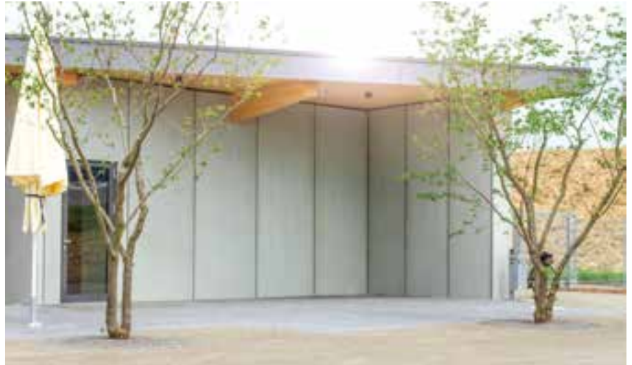
Bild 1: Ansicht der Vorhangfassade, die mit der Carbonbewehrung soligrid® Q140-CEP-38 bewehrt wurde
