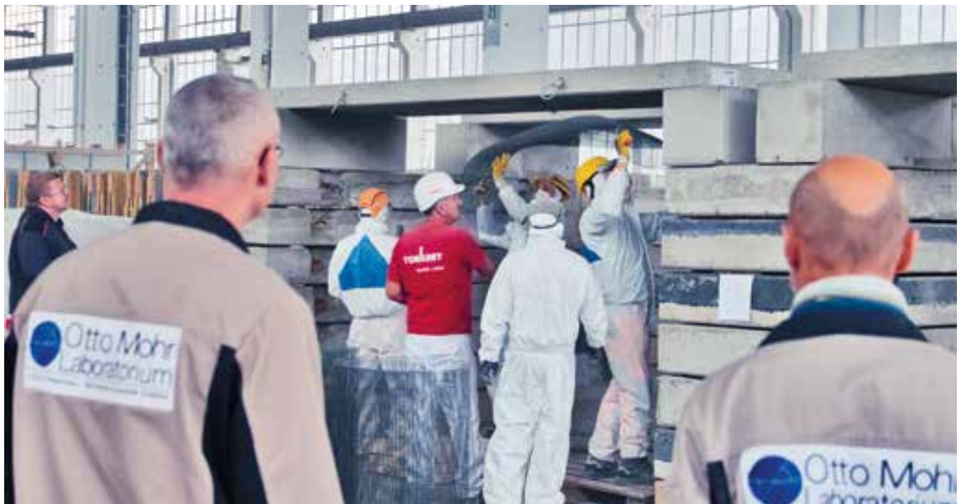
Baustellenfachpersonal bei der Verstärkung einer 4 m langen Stahlbetonplatte.
