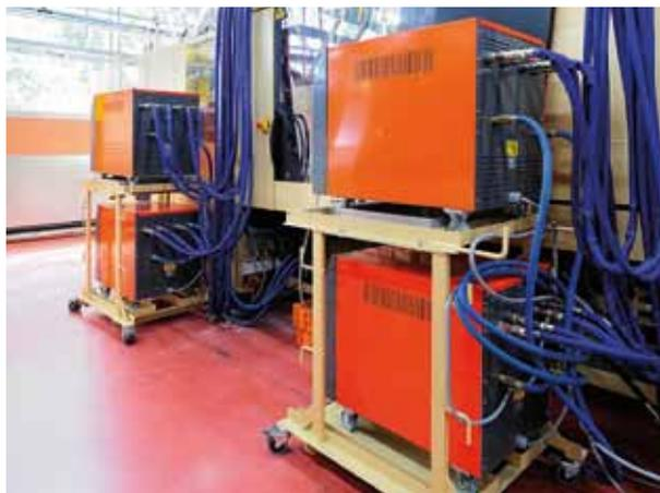
Bei der Julius Blum GmbH in Höchst installiert WITTMANN TEMPRO plus D Temperiergeräte. Transportwagen mit zwei Ebenen minimieren die Stellfläche. Neben einer Durchflussmessung mittels Ultraschall verfügen die Zweikreisgeräte über diverse weitere Sonderfunktionen.
