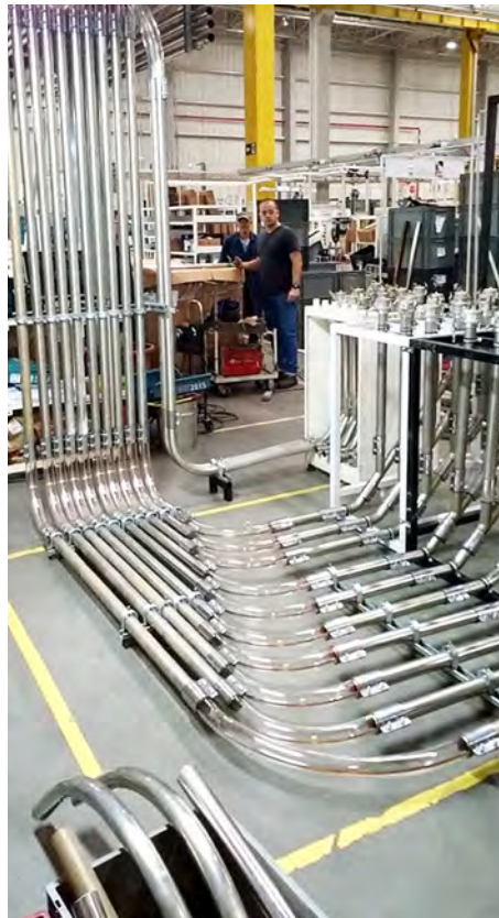
Ansicht der Anlage nach Abschluss der Installationsarbeiten.
