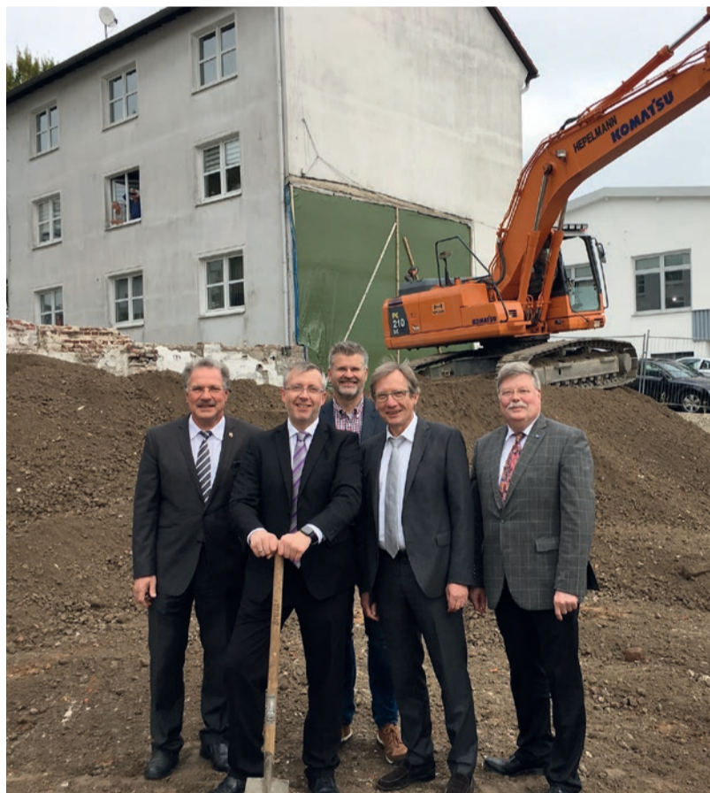
Erster Spatenstich: Bürgermeister Dieter Dzewas, PTC-Leiter Dr. Andreas Balster, Geschäftsführer Stefan Schmidt, Aufsichtsratsvorsitzender Matthias Poschmann und Andreas Lux, Geschäftsführer der Trägergesellschaft Kunststoff-Institut Lüdenscheid e. V.)
