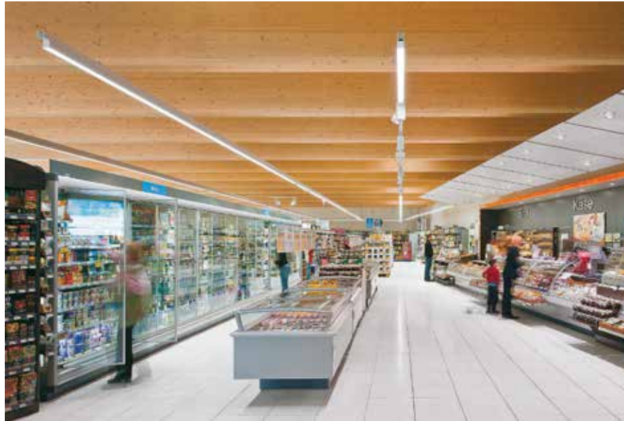
Das LED-Lichtbandsystem von Zumtobel kommt abgesehen von Supermärkten auch häufig in Industriehallen, Büros oder Bildungseinrichtungen zum Einsatz. Fotos: Zumtobel
