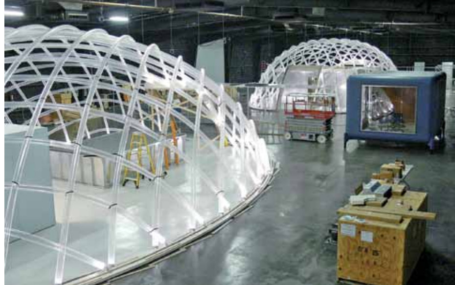
Montage: Die unter Unterdruck stehende Hüllfolie stabilisiert die zunächst aufgebauten Schlauchelemente Bildquelle: Studio LTA
