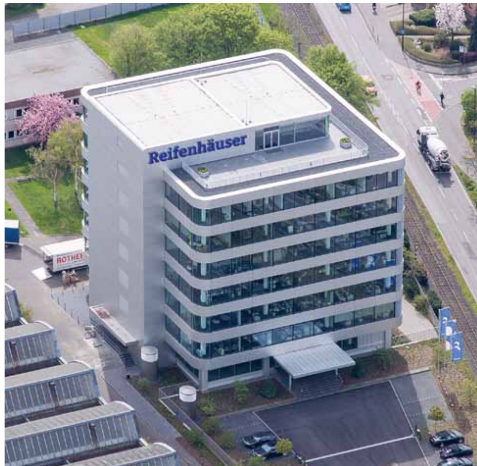
Das revitalisierte Verwaltungsgebäude setzt ebenfalls neue Standards
