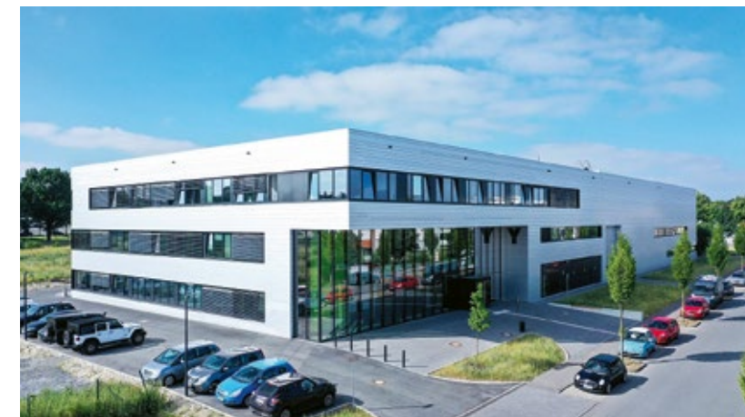
Außenansicht des Gebäudes „Y“ am Mersinweg
