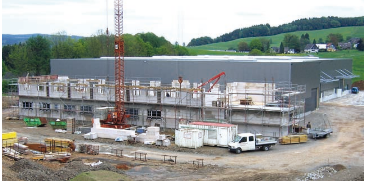
Baufortschritt in Meinerzhagen am 11. Mai 2009.
